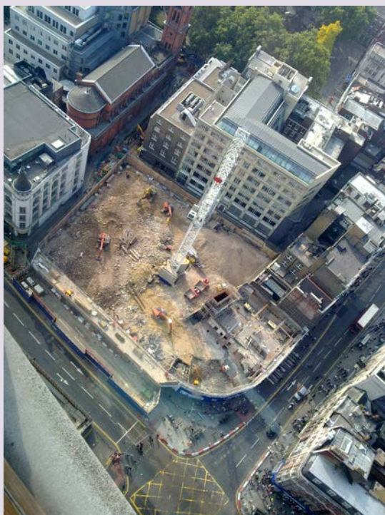
Site de la construction du RER de Londres, station Tottenham Court Road.
